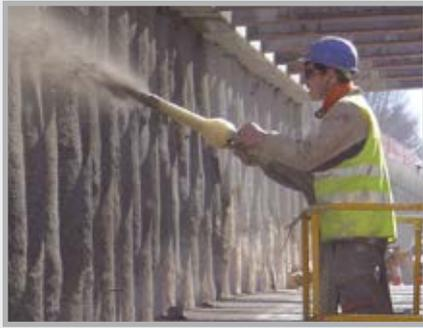
Le pompe per il calcestruzzo fine, come la P 715, vengono annoverate tra i sistemi più poliedrici. Possono essere impiegate per il calcestruzzo a proiezione oppure per il pompaggio di calcestruzzo fine fino a 16 mm.
